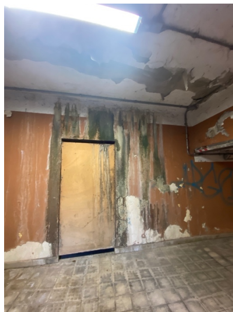
Infiltrazioni interne al sottopasso lato Nord
